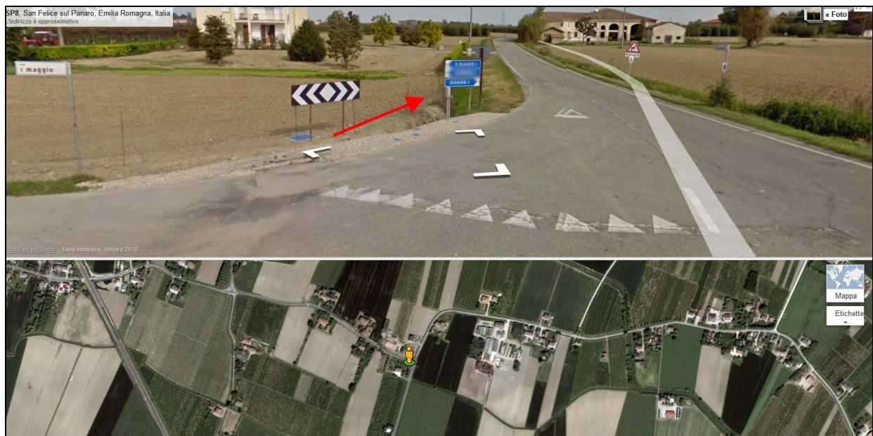
Figura 4.1 – Immagine della strada alla stato attuale con il fosso 56 a bordo strada.
