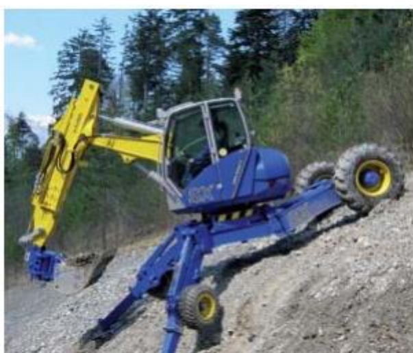
Figura 100 – Escavatore del tipo Ragno
