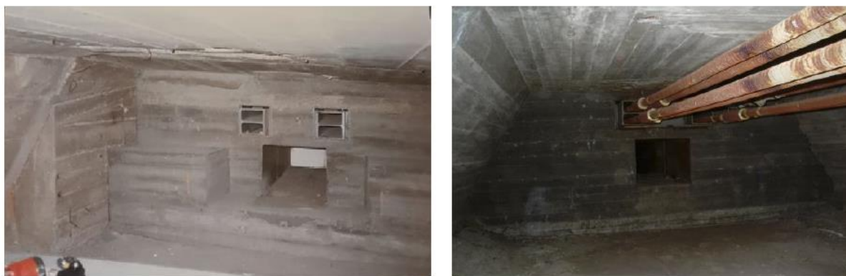
Figura 60 - Vista del blocco di testata della mensola su pila 4 a getto ultimato (a) e barre di cucitura (b)
