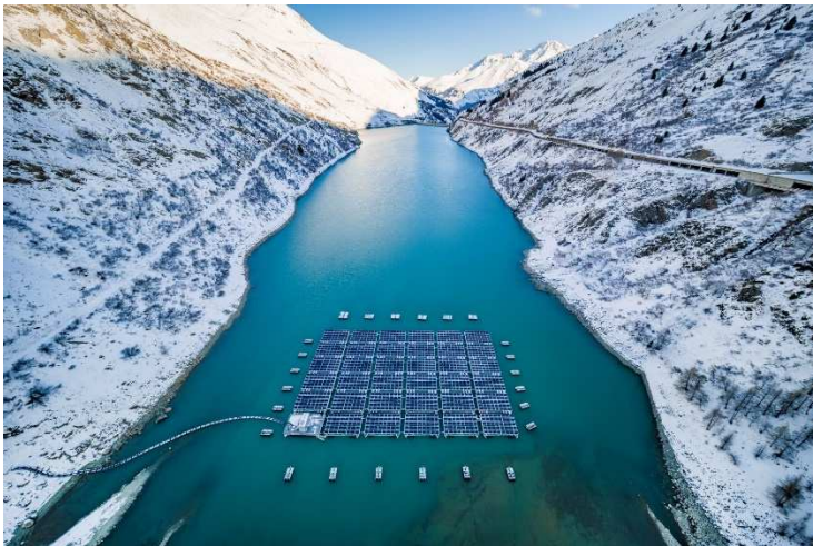
Figura 7.8. Esempio di impianto fotovoltaico flottante in un bacino svizzero.
