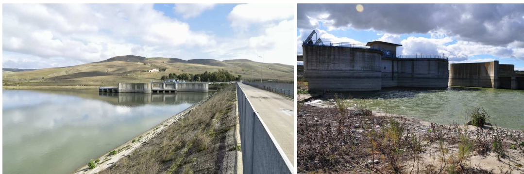
Figura 2.5. Alcune immagini delle strutture esistenti per i prelievi irrigui gestite da EIPLI.
