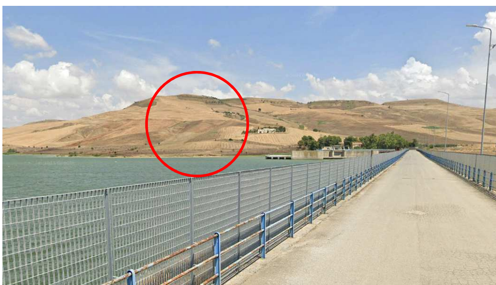
Figura 2.3 La diga di Serra del Corvo e la localizzazione dell'area in cui verranno posate le condotte forzate e verrà realizzata la centrale di produzione, completamente interrata.
