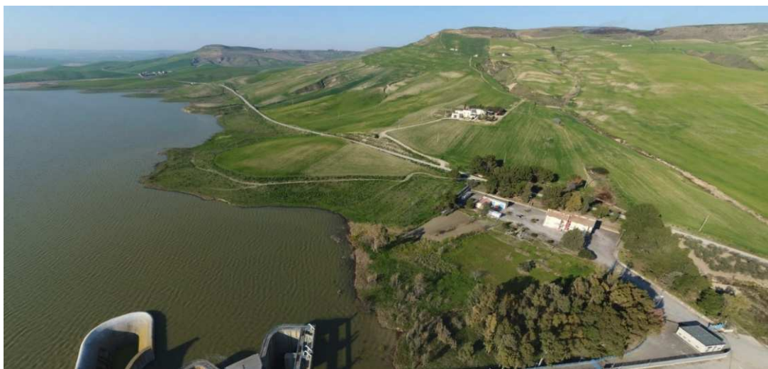
Figura 2.6. Vista aerea dei siti in cui verrà realizzata la centrale interrata e verranno posate le condotte forzate.
