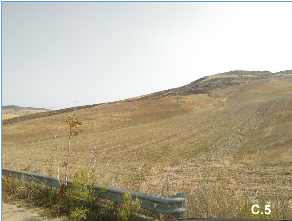
Figura 13. Il tracciato delle condotte forzate visto dalla strada vicinale di Contrada Basentello.
