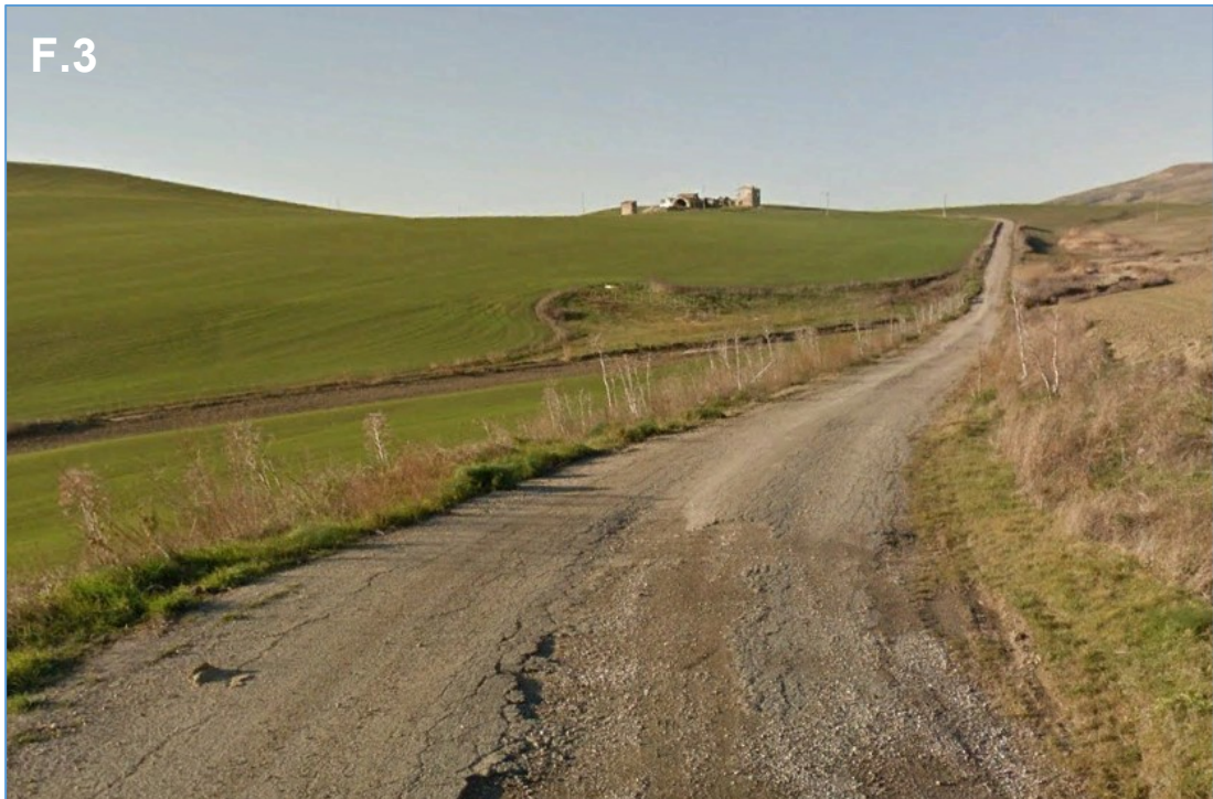
Figura 22. Il tracciato dell'elettrodotto aereo lungo la SP203 vista verso nord.
