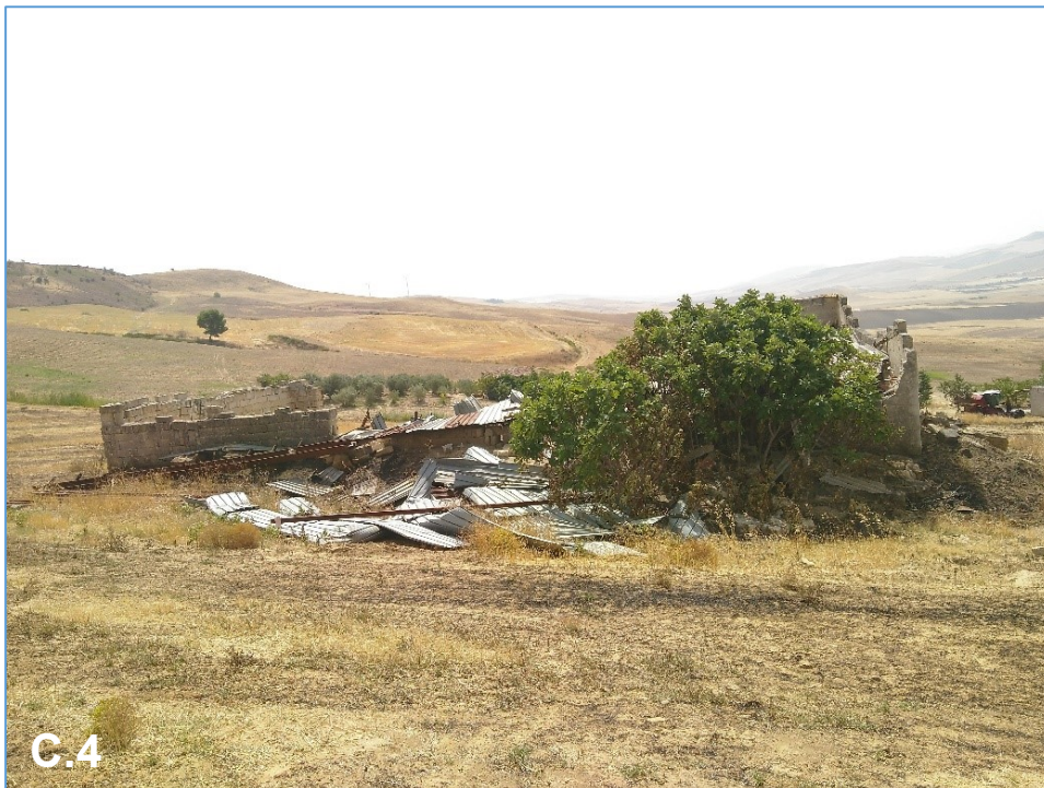
Figura 12. Uno dei ruderi non vincolati vicino al quale transiteranno le condotte forzate.
