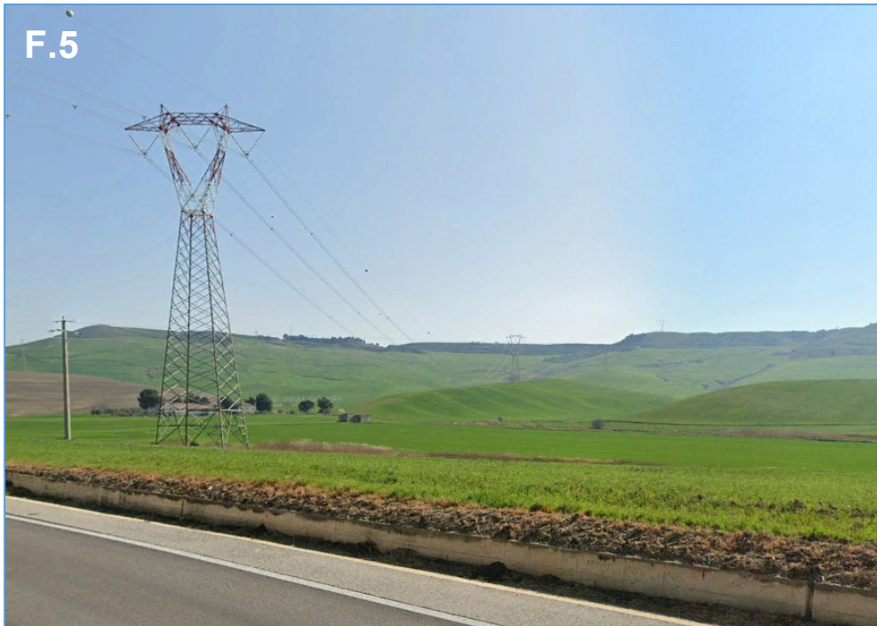
Figura 24. Vista verso sud dalla SS96 dei territori attraversati dall'elettrodotto aereo.
