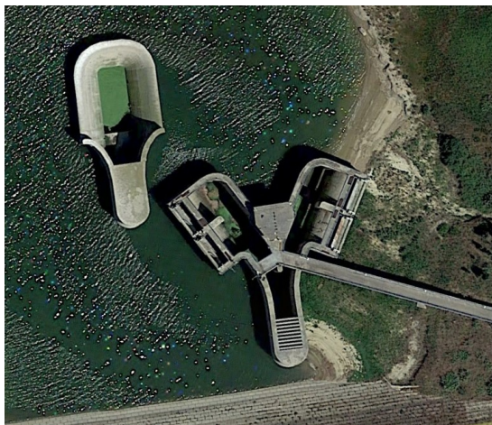
Figura 3.2. Vista dall'alto degli scarichi di superficie esistenti.
