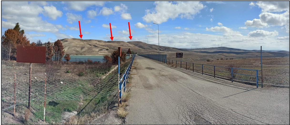
Figura 7. Vista panoramica del versante occidentale di Monte Marano. Le frecce indicano la paleo - superficie sommitale a morfologia sub - pianeggiante. In primo piano il corpo diga del bacino di Serra del Corvo.
