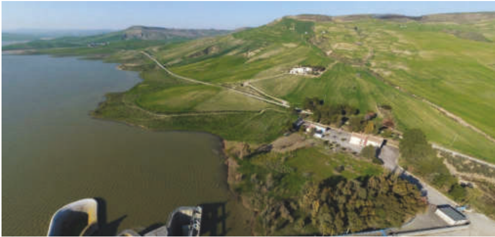
Figura 9. Vista aerea dei siti in cui verrà realizzata la centrale interrata e verranno posate le condotte forzate.
