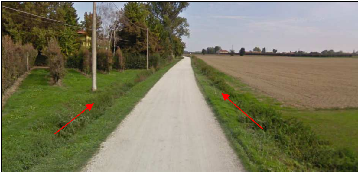
Figura 4.1 – Immagine della strada alla stato attuale con i Fossi 59 (in sinistra) e del Fosso 60 (in destra) esistenti
