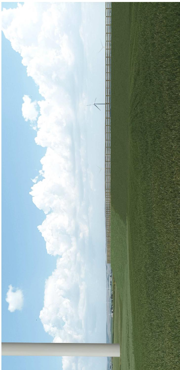
**Figura 197.** Paramenti esterni delle arginature del bacino di monte completamente rinverdite e profilate con pendenze molto dolci. Sono inseriti in primo e secondo piano anche gli aerogeneratori del nuovo parco eolico in fase di autorizzazione denominato “Monte Marano”.
