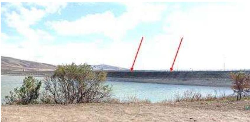
**Figura 62.** Paramento di monte della diga. Le frecce indicano la presenza di vegetazione tra le piastrelle del paramento di monte.
