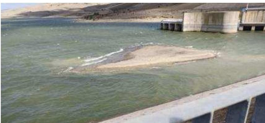
**Figura 63.** Sedimenti accumulati in corrispondenza del paramento di monte.
