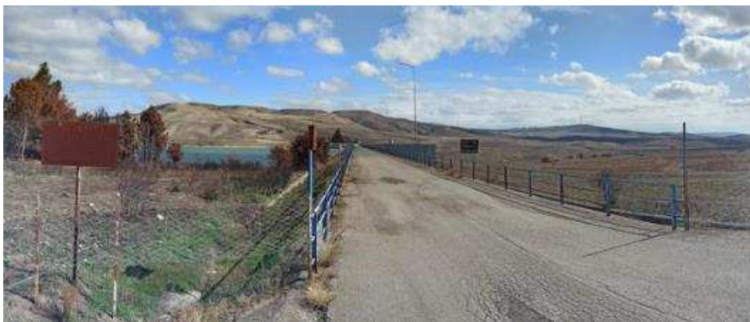
**Figura 64.** Stato di abbandono di recinzioni, cartellonistica, vegetazione e strada visibilmente ammalorata.
