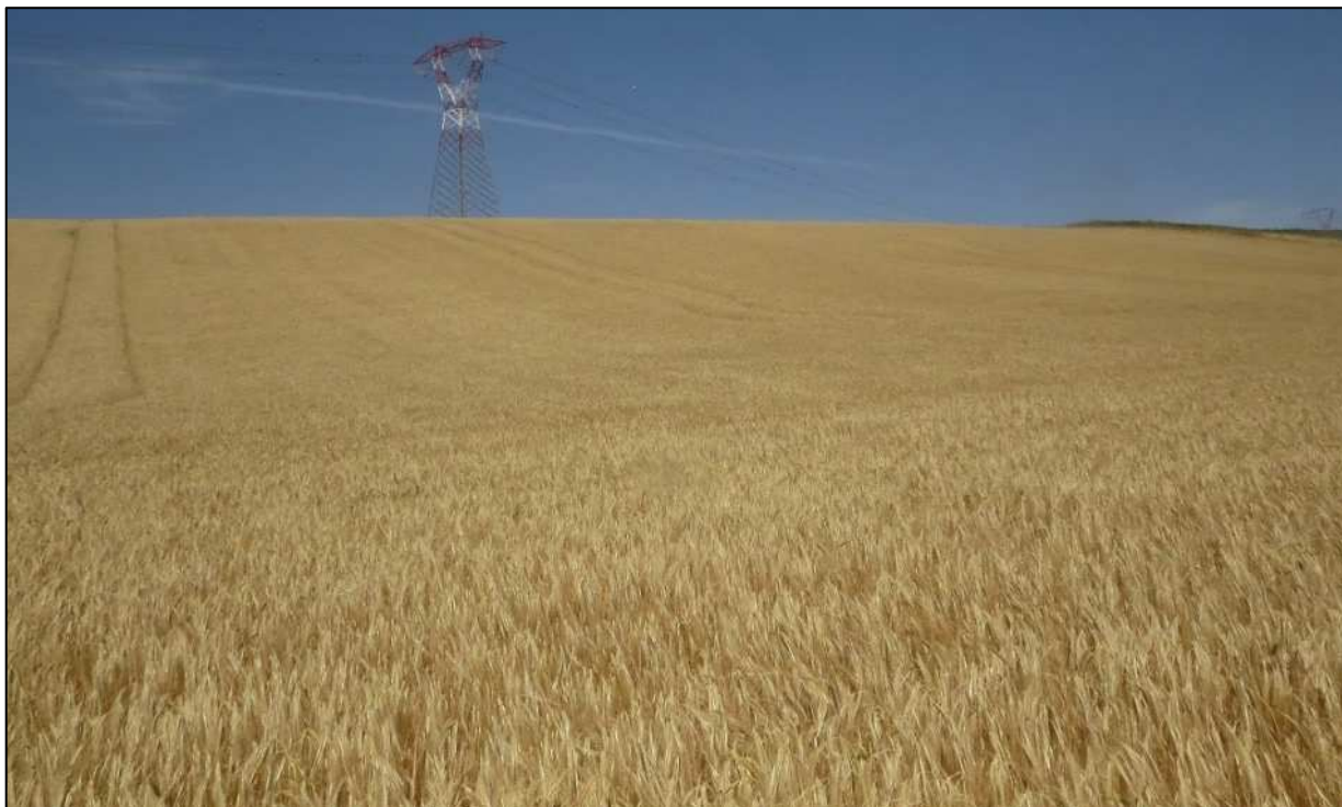
FIGURA 31 – Vista panoramica del sito dove ricade il traliccio n. 23
