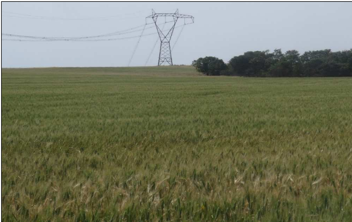
FIGURA 33 – Vista panoramica del sito dove ricade il traliccio n. 25
