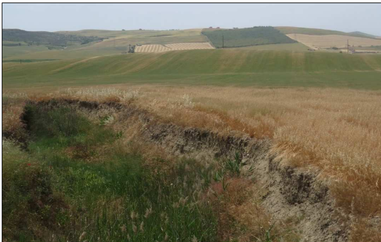
FIGURA 16 – Vista panoramica del sito dove ricade il traliccio n. 6
