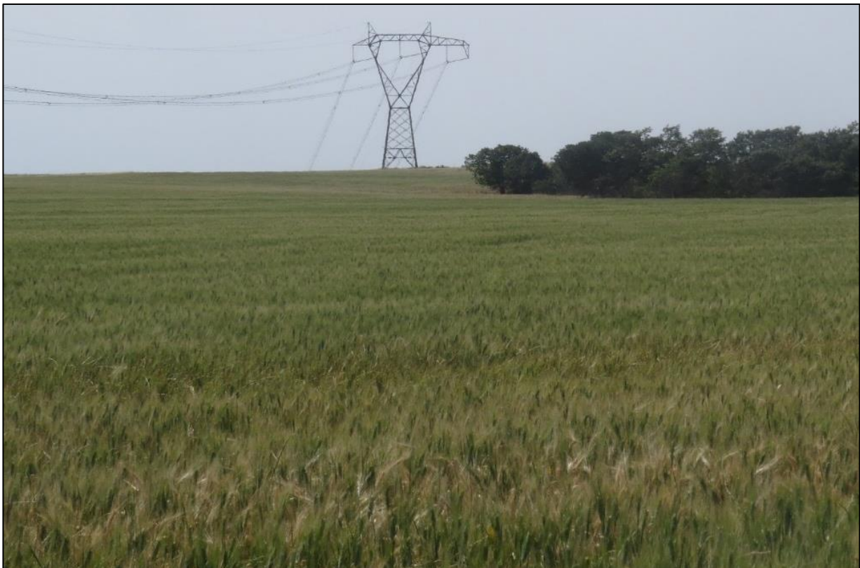
FIGURA 31 – Vista panoramica del sito dove ricade il traliccio n. 25
