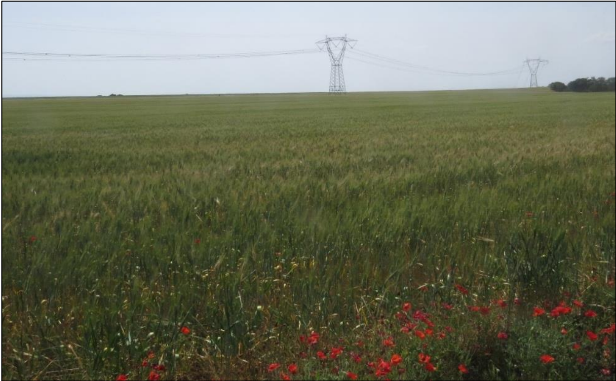
FIGURA 32 – Vista panoramica del sito dove ricade il traliccio n. 26
