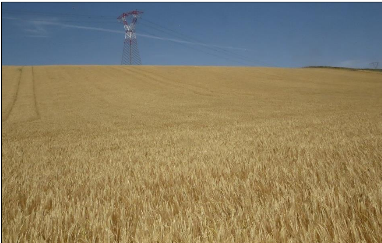
FIGURA 29 – Vista panoramica del sito dove ricade il traliccio n. 23
