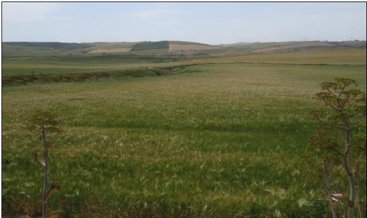
FIGURA 13 – Vista panoramica del sito dove ricade il traliccio n. 5
