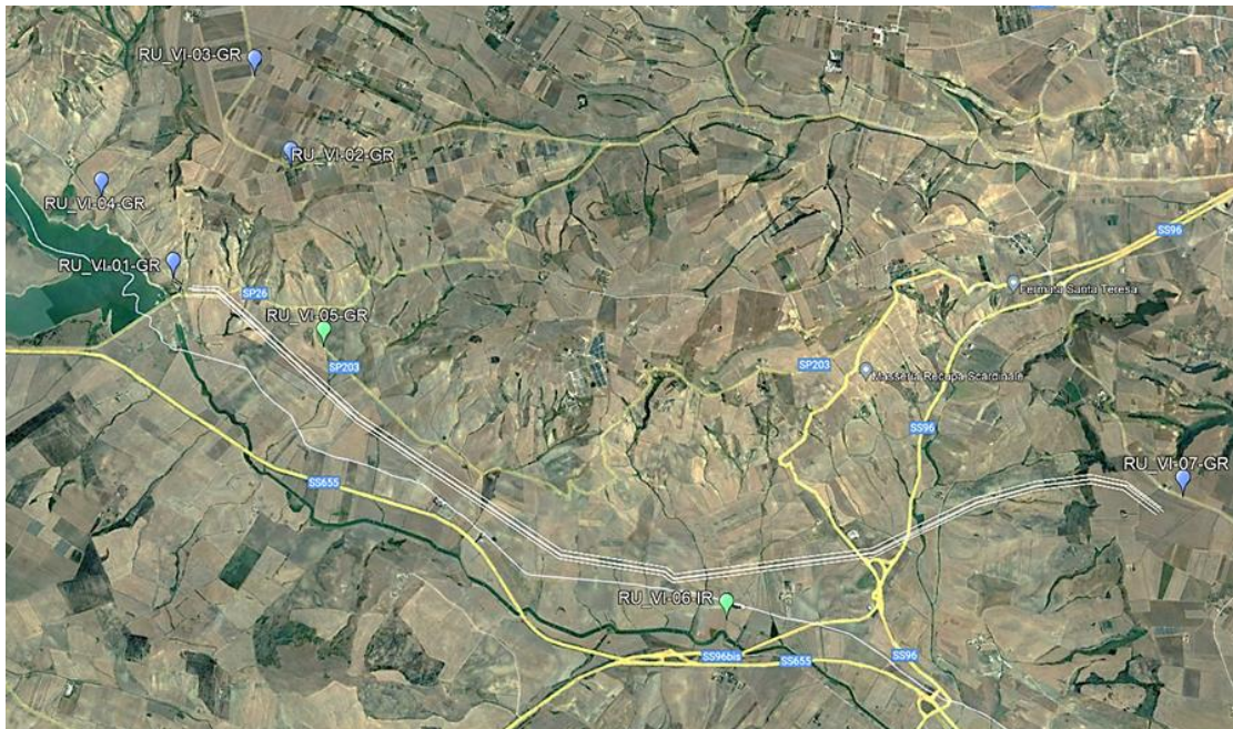
Figura 4. Localizzazione dei punti di misura del rumore e delle vibrazioni ambientali.
