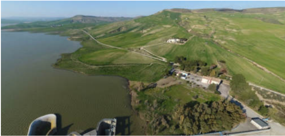
Figura 9. Vista aerea dei siti in cui verrà realizzata la centrale interrata e verranno posate le condotte forzate.
