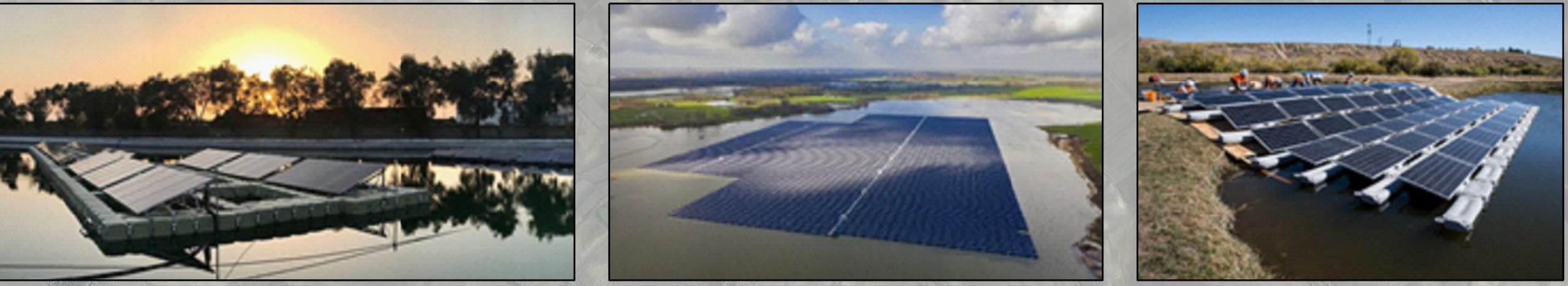
CA-008 Impianto fotovoltaico flottante
