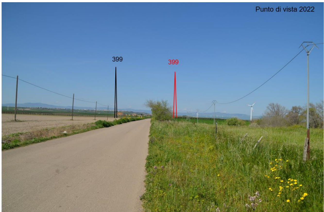
Foto 26 - Punto di vista localizzato nel Comune di Lucera nel 2022 con opere
