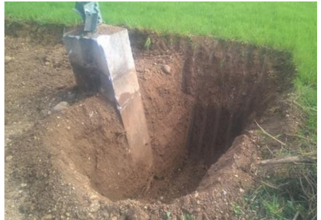
Figura 7 - Esempio di rimozione della fondazione superficiale di un sostegno 220 kV (a sx) e 380 kV ST (a dx).
