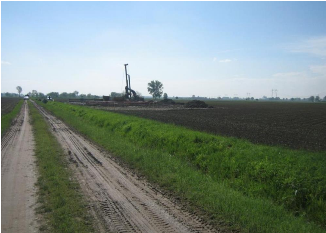
Figura 1 - Esempio di micro cantiere con pista di accesso
