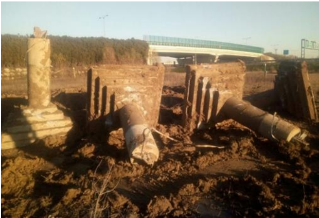
Figura 7 - Esempio di rimozione della fondazione superficiale di un sostegno 220 kV (a sx) e 380 kV ST (a dx).
