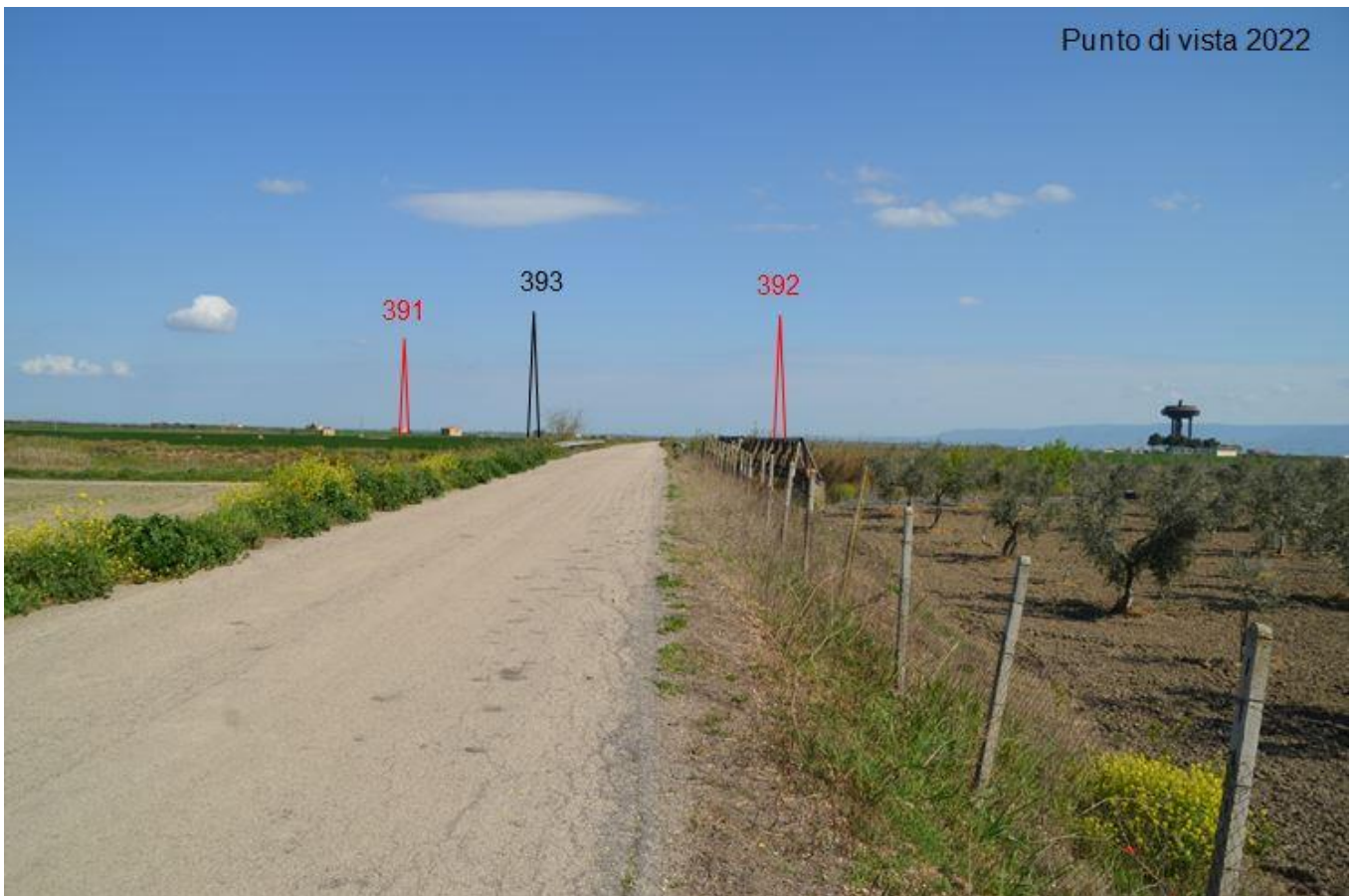
Foto 22 - Punto di vista localizzato nel Comune di Lucera nel 2022 con opere
