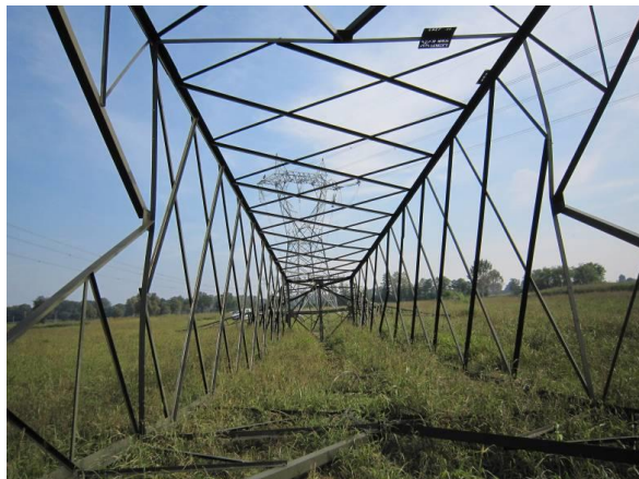
Figura 5 - Fasi demolizione di un sostegno a traliccio
