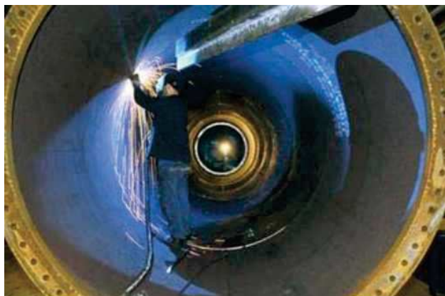
Figura 10 - interno di una torre
