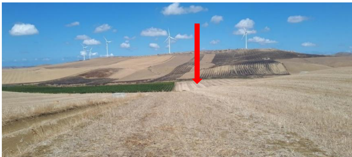
Figura 5-21. Panoramica dell'area e indicazione del punto dove sorgerà l'aerogeneratore WTG 6
