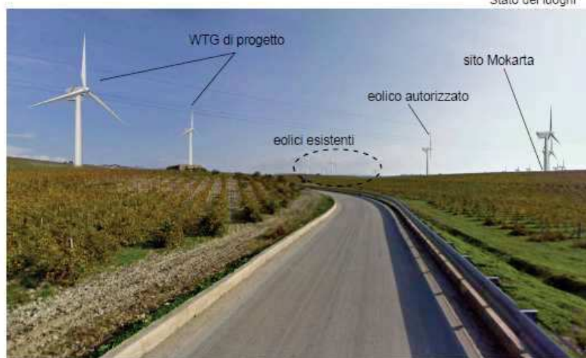
Figura 2 - fotoinserimento vista n°1 verso sito Mokarta con WTG di progetto, autorizzati ed esistenti
