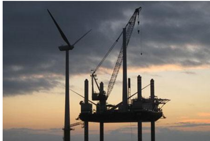
Figura 30 – Struttura per il rizzaggio dell'opera
