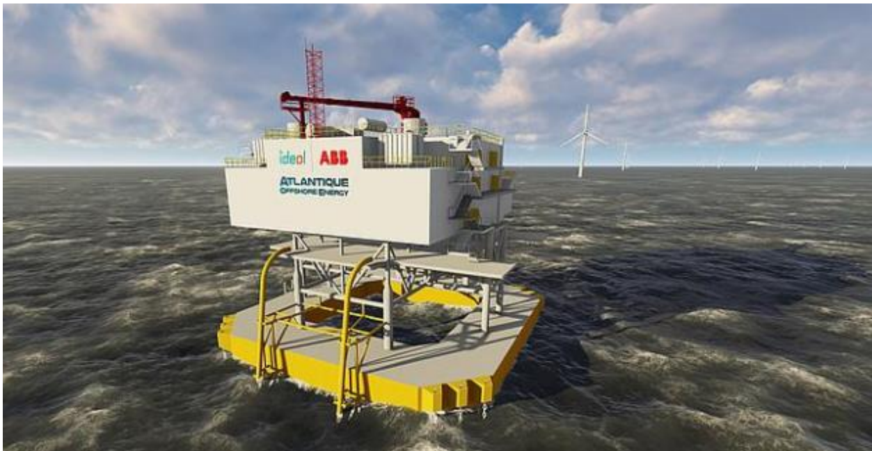
Figura 18 – esempio di Stazione elettrica galleggiante – Fonte: ideol
