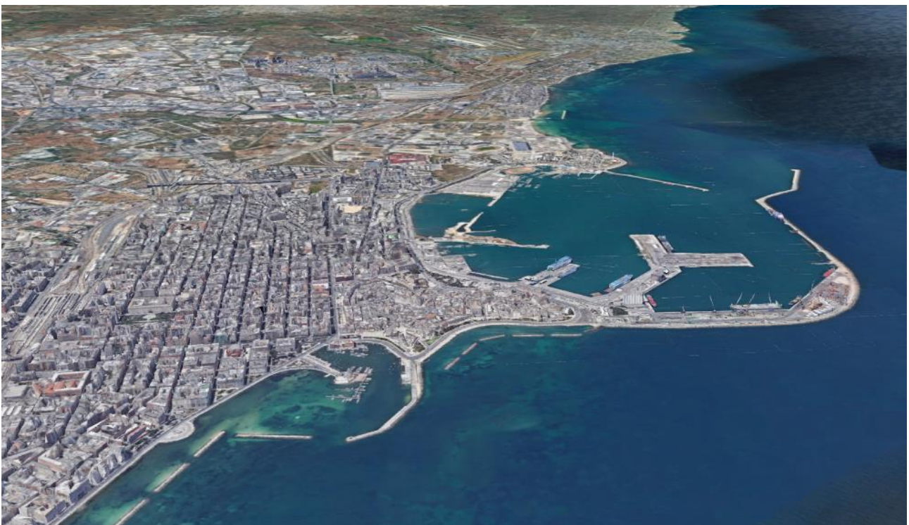
Figura 25 – vista aerea porto di Bari
