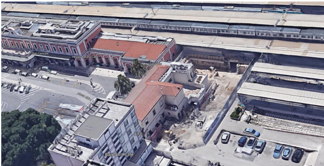
Immagine tratta da Google Earth risalente al periodo di realizzazione dello scavo
