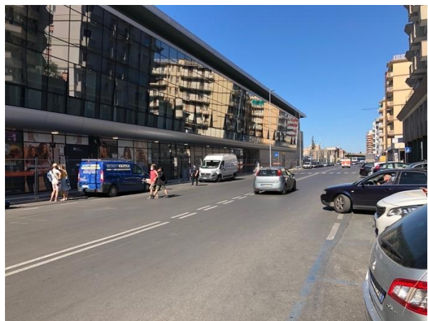
La pensilina della Stazione Centrale ed il nuovo FV su Via Capruzzi
