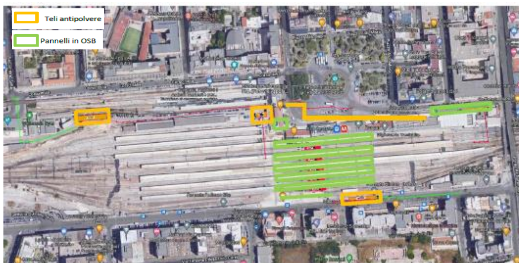
Figura 69:Teli antipolvere e pannelli in OSB
