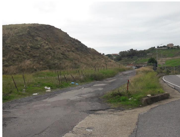
Figura 4-29: Transito lungo i margini di area segnalata a pericolosità frana lungo la SS19b presso Barone
