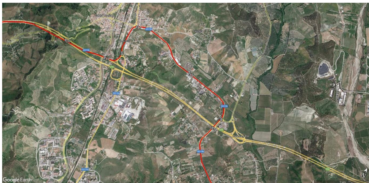
Panoramica del percorso del cavo a 150 kV in prossimità della località di Le Croci (CZ).
