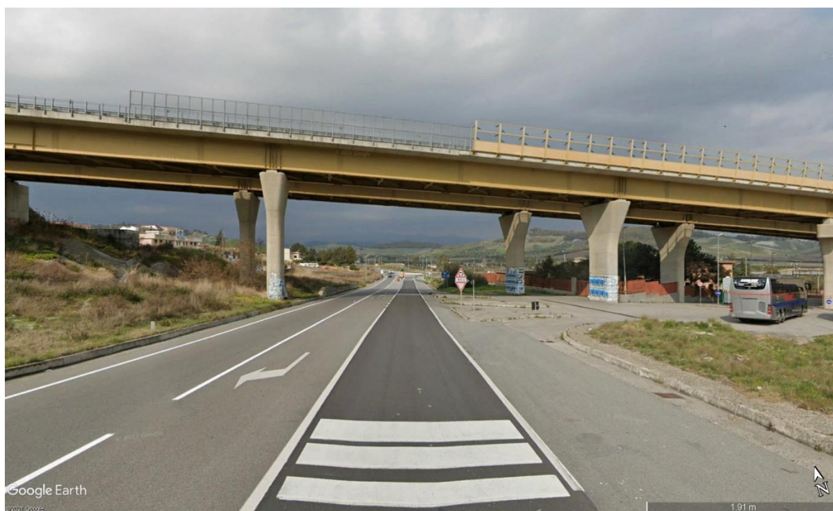
Vista 14: Continuazione sulla Via Emilia (SS19b) in direzione Nord.
