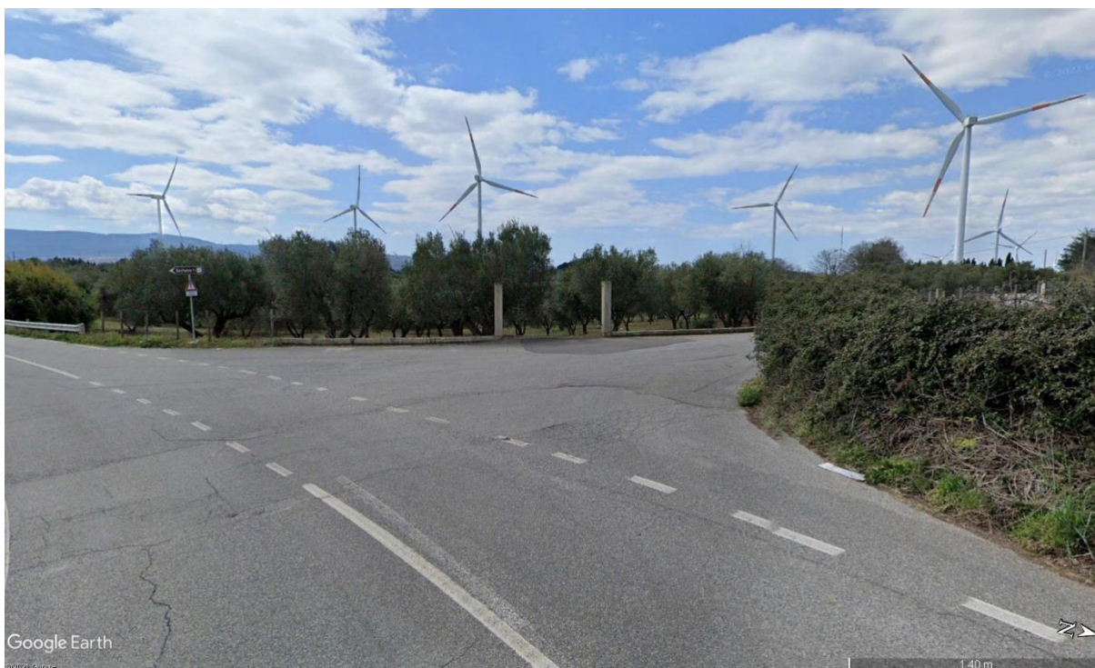
Vista 41: Deviazione sulla strada locale che porta verso la SE Maida 380 kV di Terna S.p.A..
