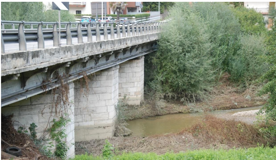
Figura 27 – Ponte esistente su Via Salaria località Mozzano
