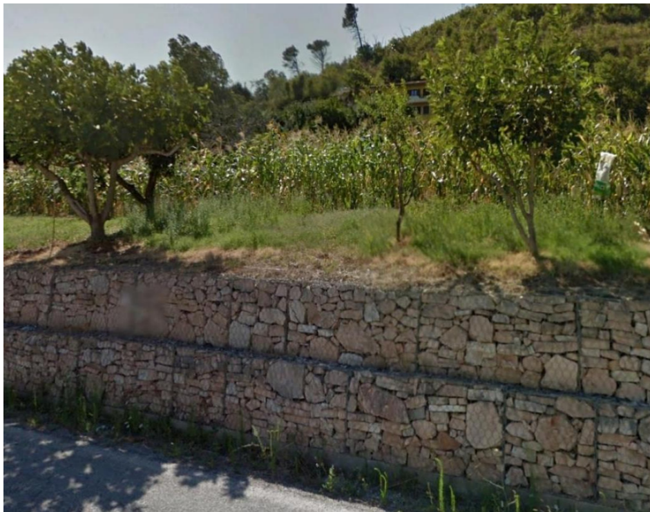
Figura 29 – Muri a gabbioni esistenti lungo Via Salaria località Mozzano
