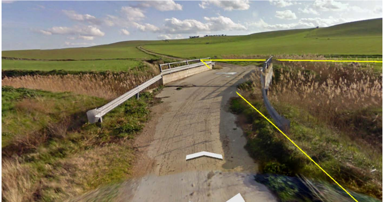
Figura 7a: Passaggio tracciato strada interpodereale direzione sud, attraversamento ponte carrabile
