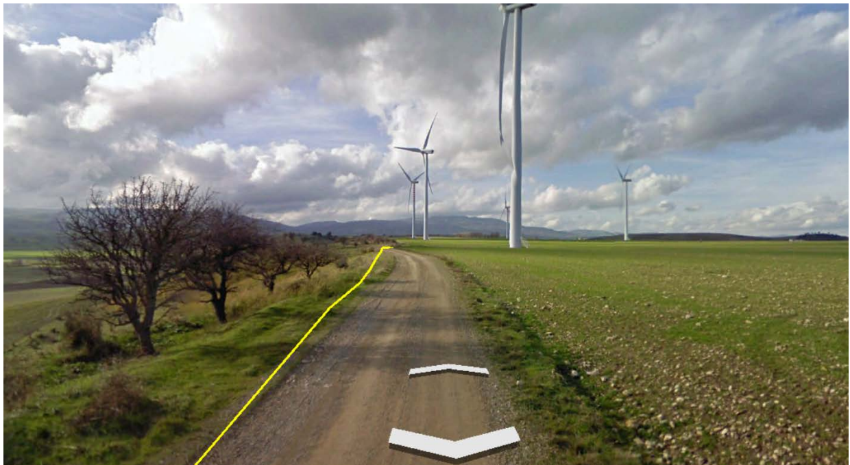
Figura 13- Tracciato su strada interpodereale, direzione ovest verso incrocio SP13
