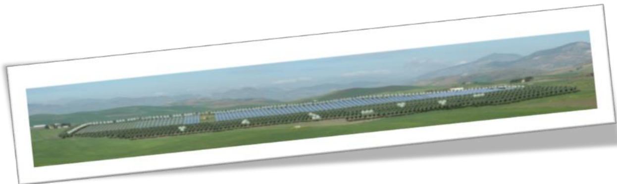
Figura 47 - Impianto fotovoltaico da 5 MW, "Heliospower", Monreale (PA) 2010
