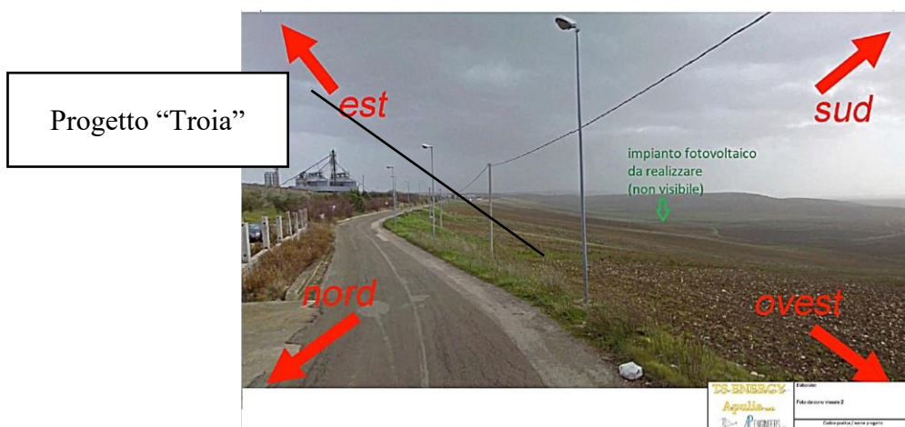
Figura 47- Veduta dal SIA di TS Energy
