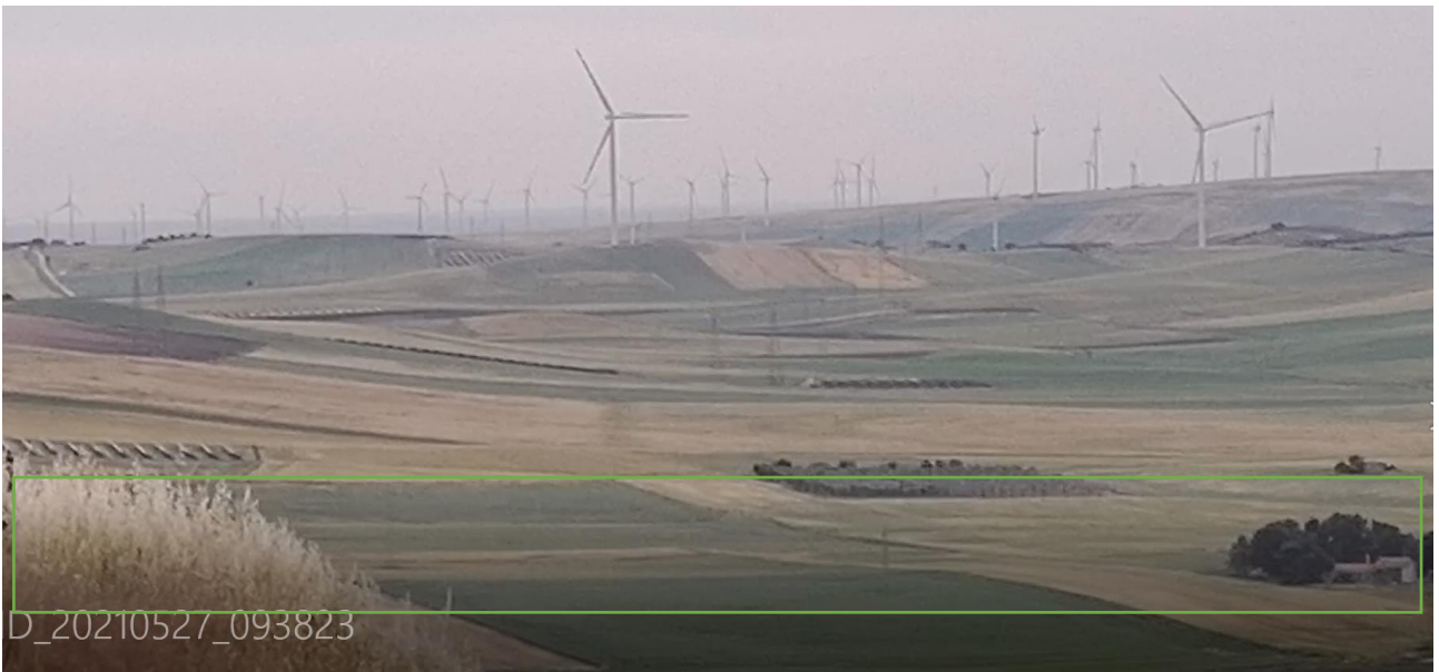
Figura 102 - Impianti eolici, tralicci Enel e area di impianto
