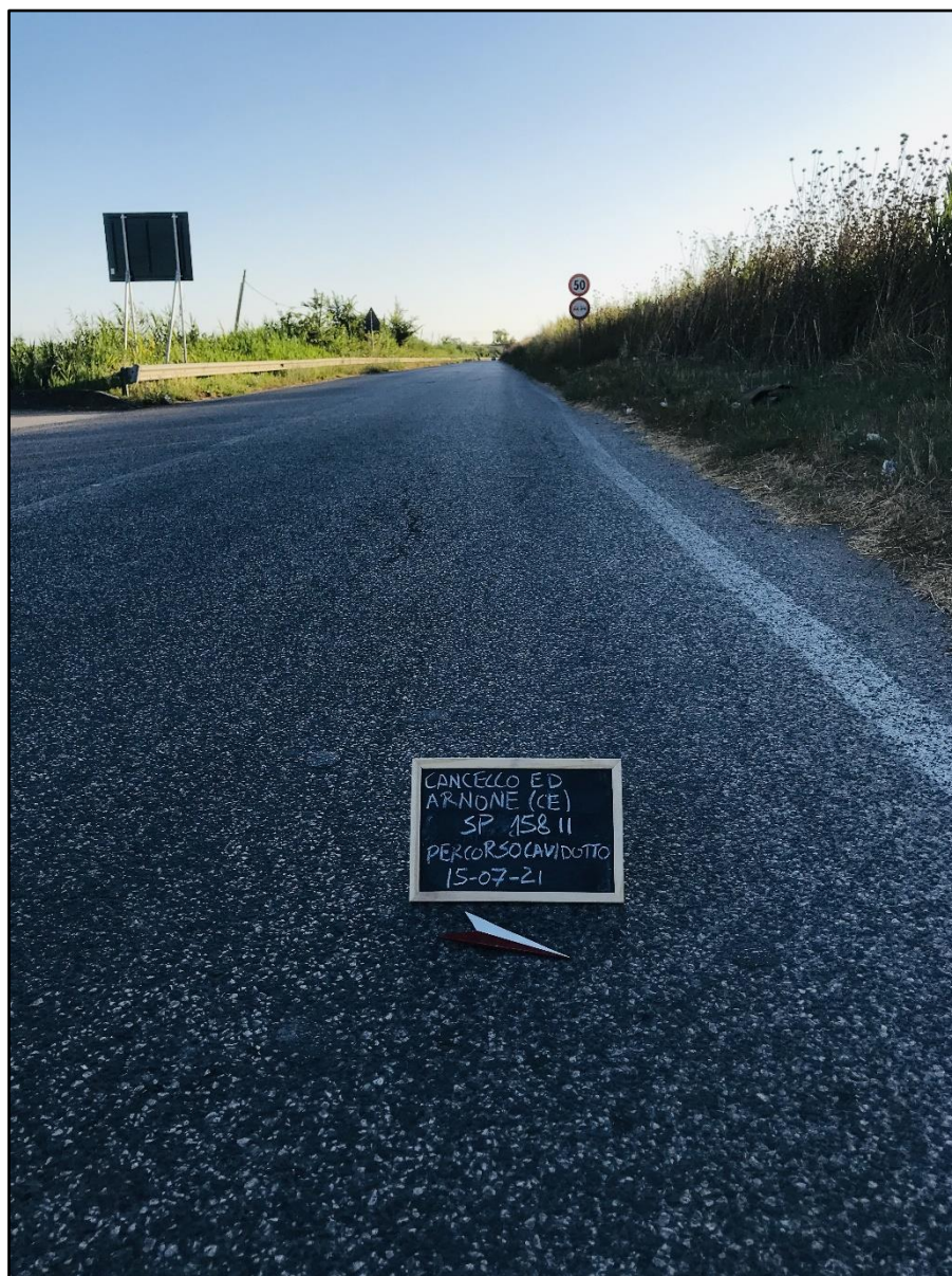
Fig. 37 - Dettaglio della SP 158, in cui verrà effettuato lo scavo per il cavidotto.
