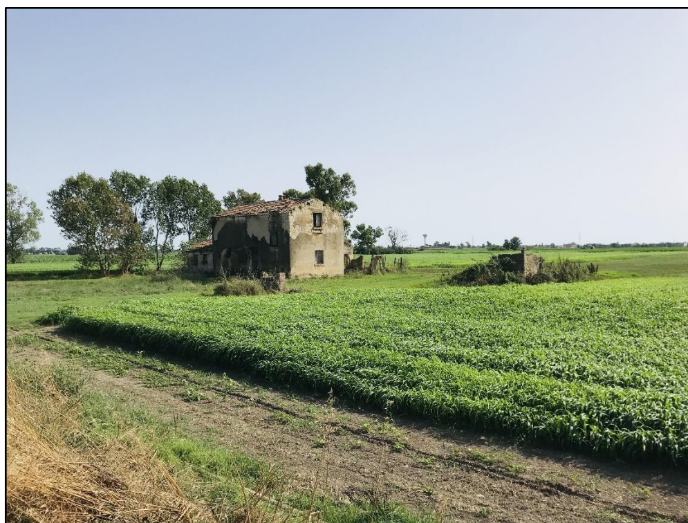
Fig. 32 - Dettaglio del rudere abbandonato nell'area R1.
