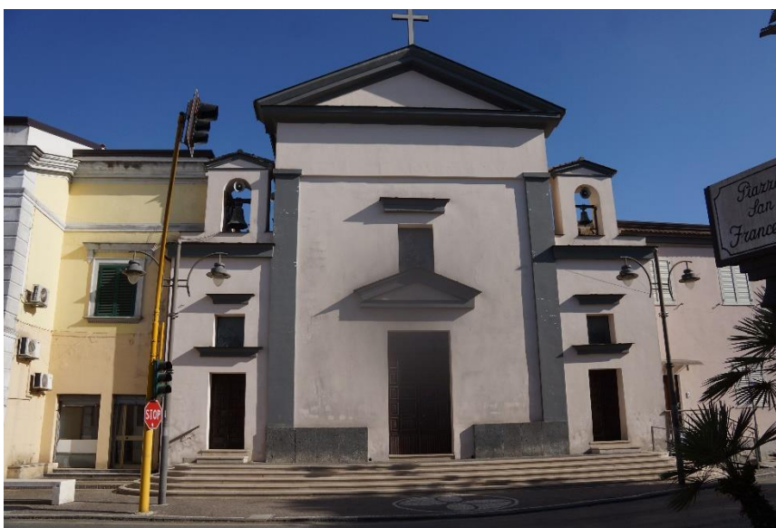
Fig. 11 - Facciata della Chiesa di Maria Regina di tutti i Santi (da foto dell'autore).
