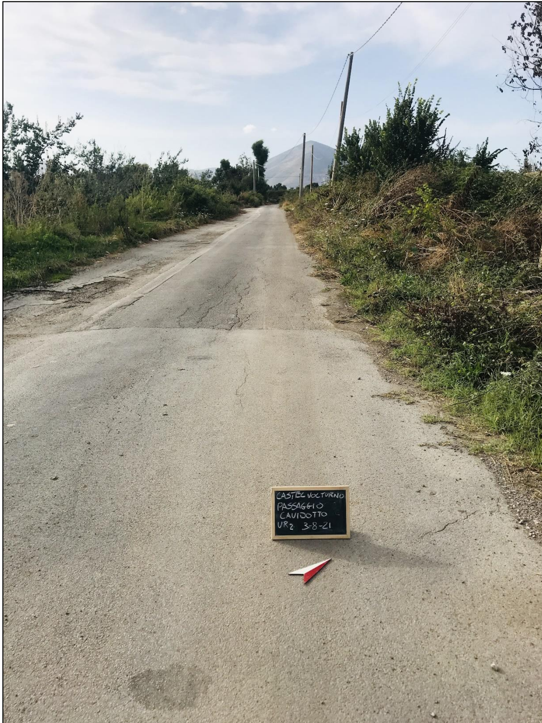
Fig. 35 - Dettaglio della strada in direzione sud-est, in cui verrà effettuato lo scavo per il cavidotto.
