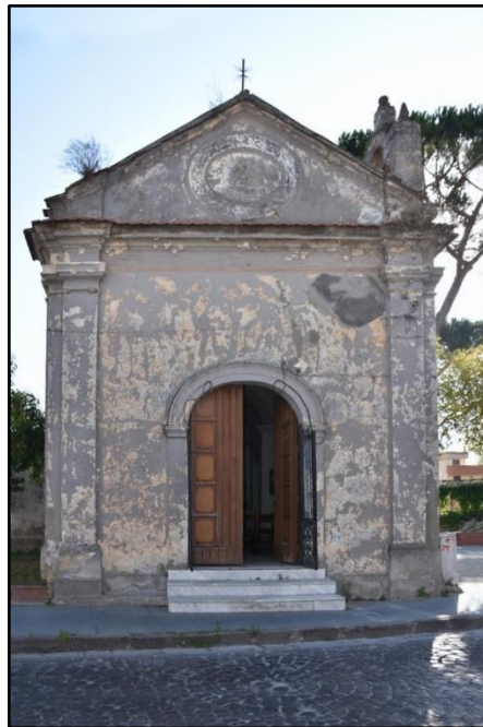
Fig. 13 - Facciata esterna della Cappella di San Rocco (da foto dell'autore).
