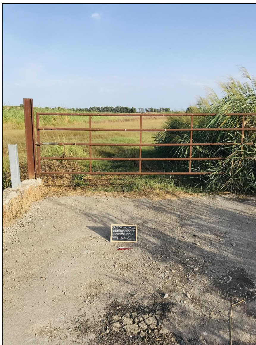
Fig. 31 - UR1, Ingresso area di intervento (da foto dell'autore).
