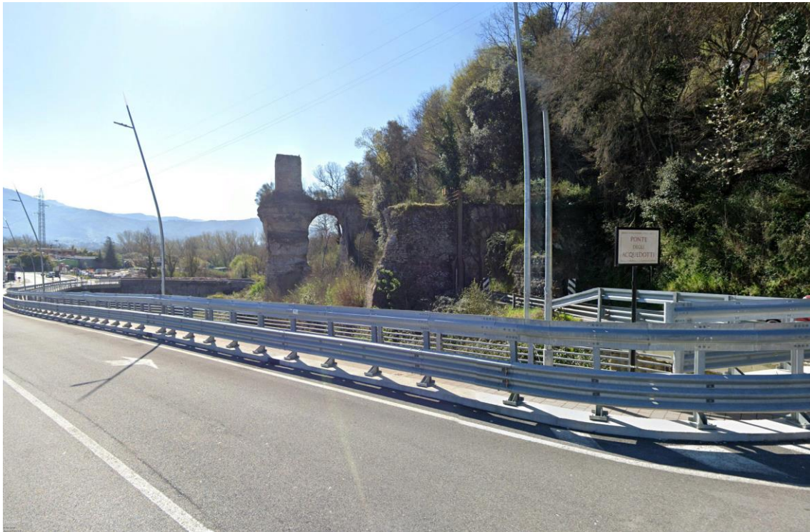
Figura 2-131 Ponte degli acquedotti (Ponte Arci) visto dalla SP33a (Google Earth immagini 2021)
