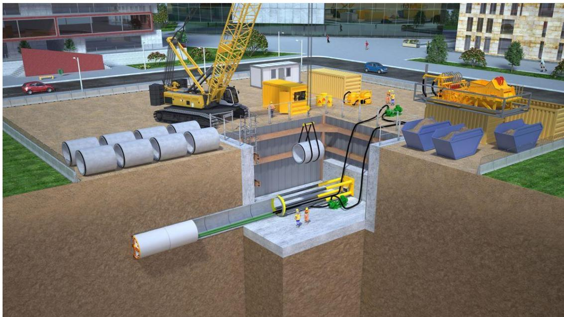
*Figura 5-14 Rappresentazione modalità di scavo in microtunnelling*
