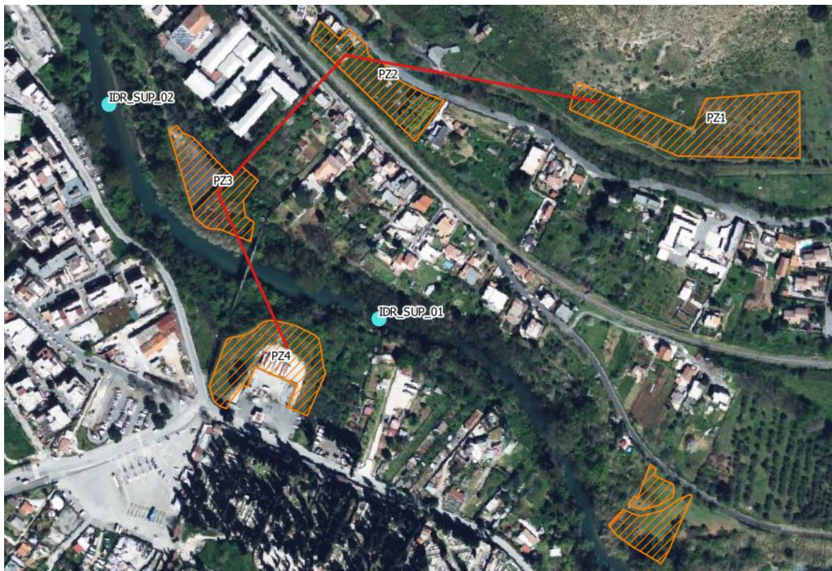
Figura 8-2 Ubicazione dei punti di monitoraggio delle acque superficiali
