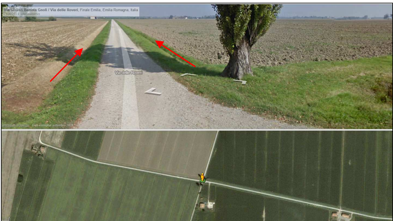
Figura 4.1 – Immagine della strada alla stato attuale con i fossi a bordo strada.
