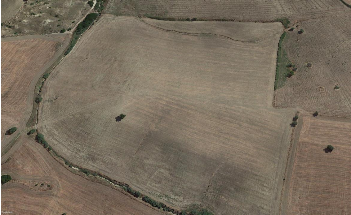
Figura 84 - inquadramento dell'area a volo d'uccello - stato di fatto
