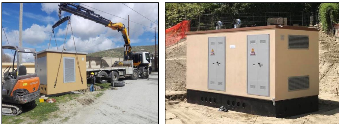
Figura 12 - Fasi di scarico cabine prefabbricate in cav
