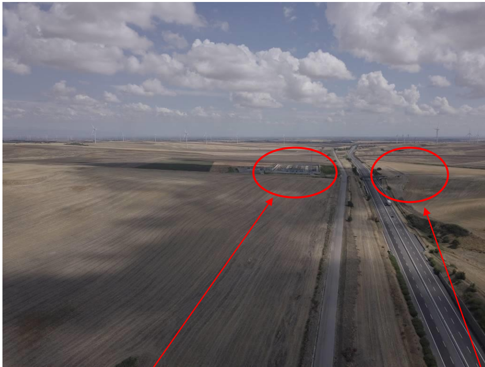
Foto 10 – Stazione RTN di Terna (a) e vista dell'area stazione elettrica di utenza (SEU) e stazione di raccolta (SER) (b)
