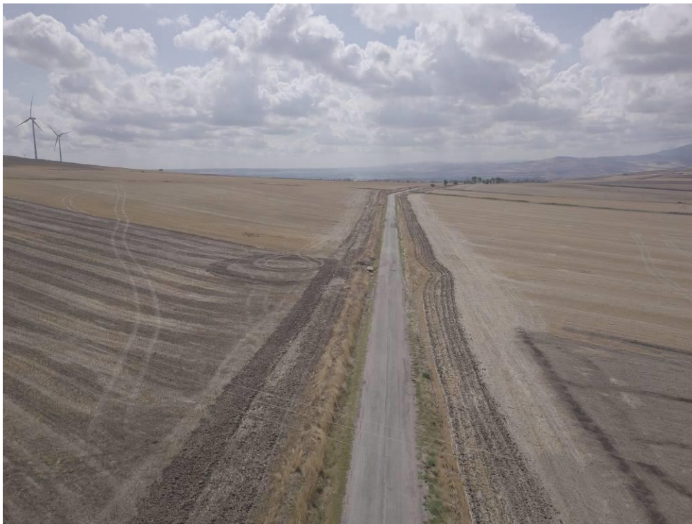
Foto 8 – SP90 passaggio cavidotto MT
