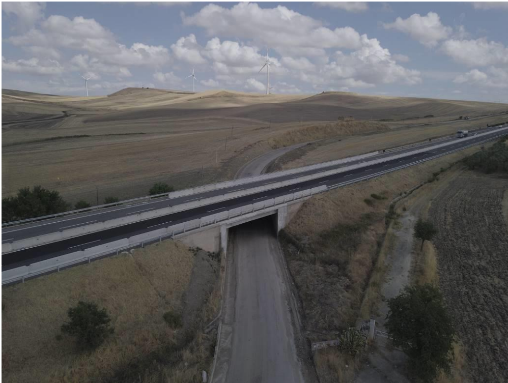
Foto 9 – SP90 passaggio cavidotto MT
