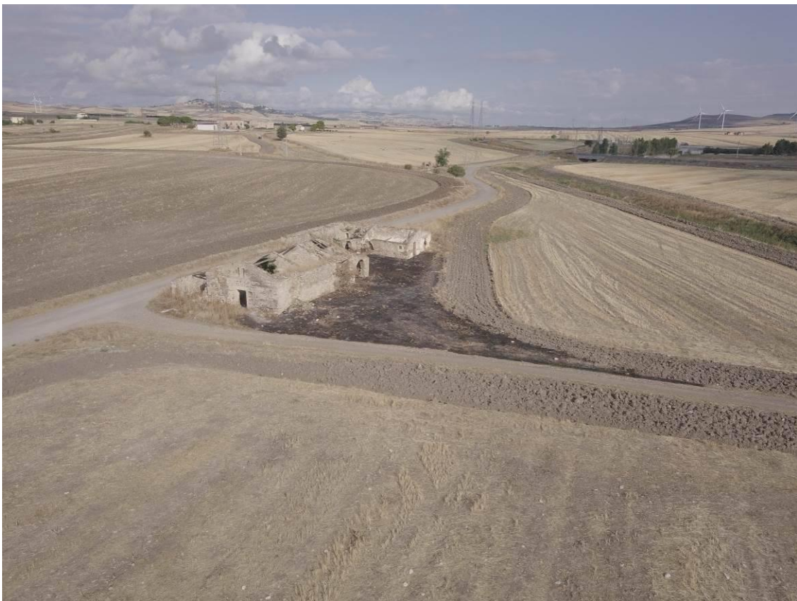
Foto 6 – Strutture di valore tipiche dell'architettura rurale
