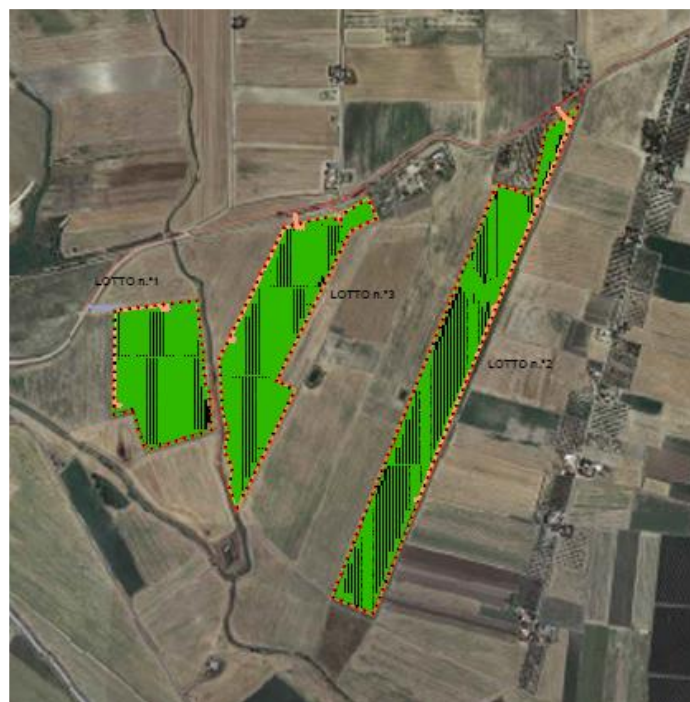
Fig. 5 – Area destinata alla realizzazione dell'impianto agrivoltaico
