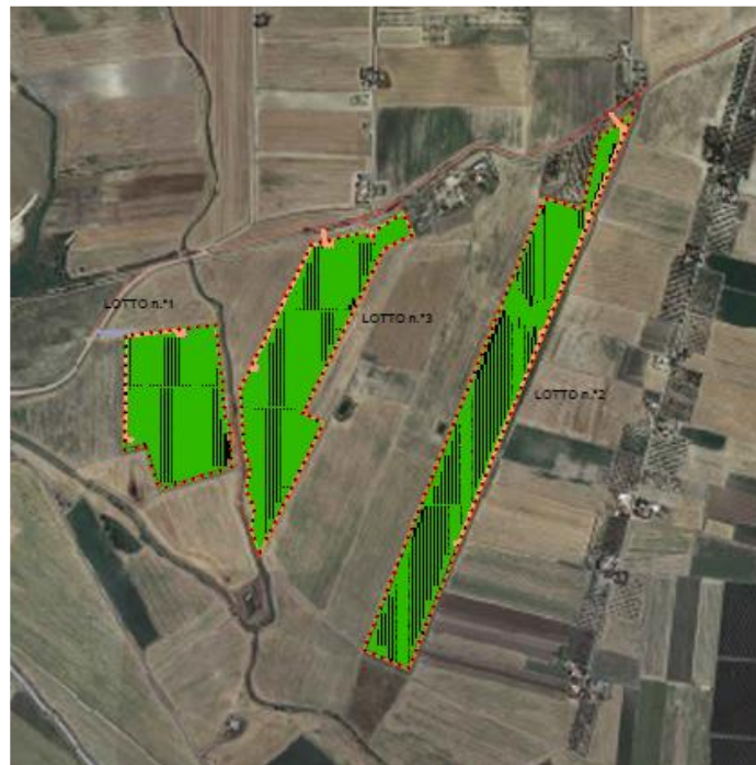
Fig. 5 – Area destinata alla realizzazione dell'impianto agrivoltaico
