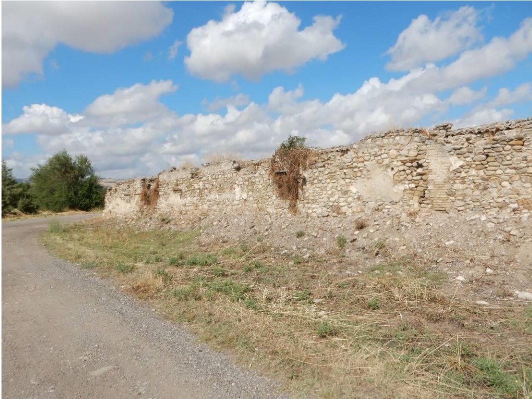
Foto 12 – Muretti a secco
