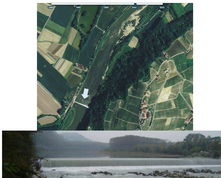
Figura 7 – Condizione della traversa nel 2006
