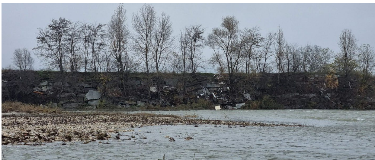
Figura 30 – Difese spondali localizzate in battuta in corrispondenza del meandro in elevato grado di dissesto ed instabilità. Si prevede il ripristino e la ricostruzione della scogliera abbattuta con la formazione di una nuova scogliera per un'estensione di 260 m
