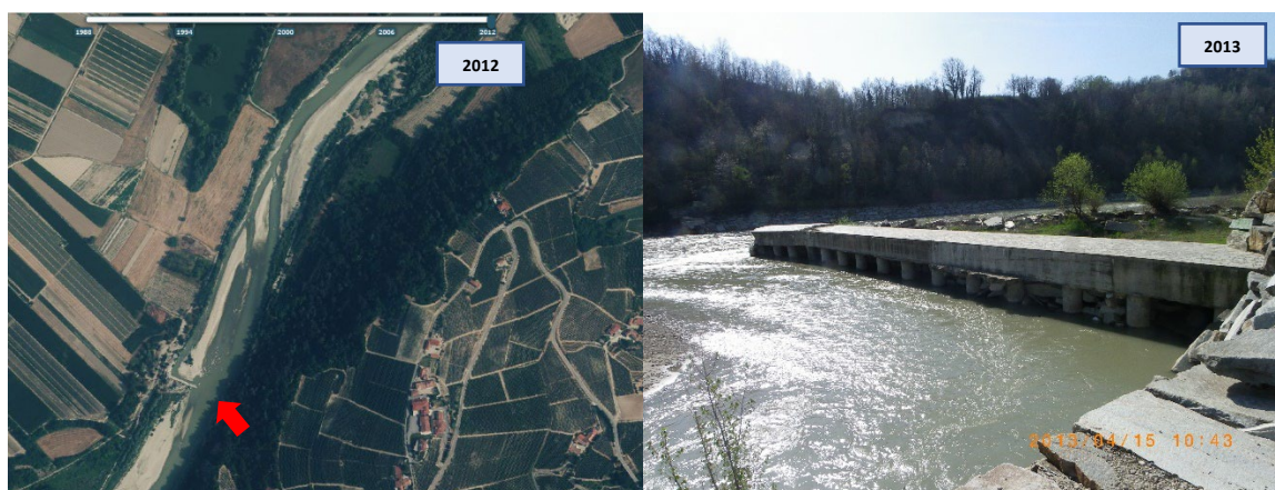
Figura 9 – Relitto della traversa negli anni successivi al crollo del 2010.
