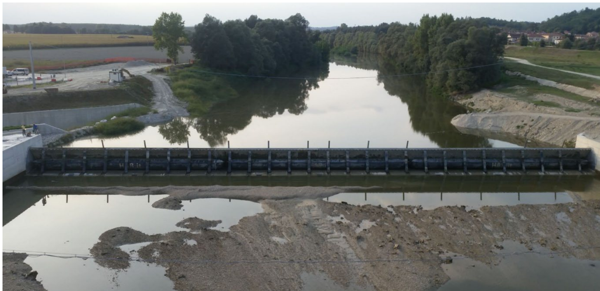
Figura 21 – Sbarramento gonfiabile scudato con singolo elemento elastomerico di gonfiaggio a valle di H=4,2\text{ m} e L=85\text{ m} analogo a quello previsto in progetto. Fase di innalzamento
