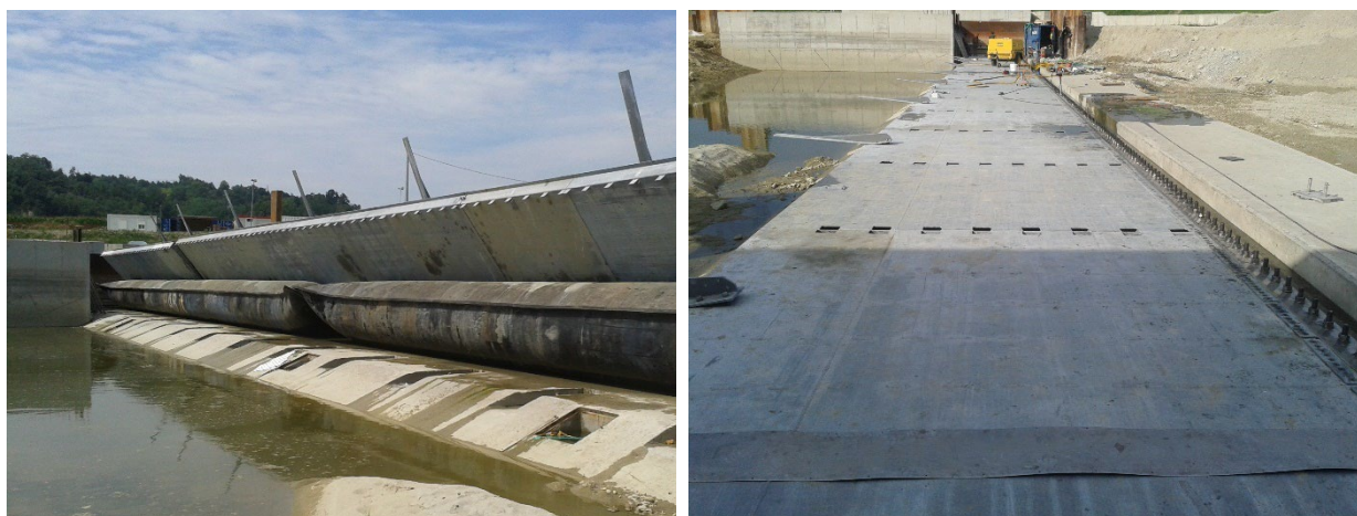
Figura 20 – Sbarramento gonfiabile scudato con singolo elemento elastomerico di gonfiaggio a valle di H=4,2\text{ m} e L=85\text{ m} analogo a quello previsto in progetto. Fasi di collaudo e gonfiaggio dell'elastomero (in sinistra) e fasi di installazione con sbarramento in posizione completamente abbattuta (in destra)
