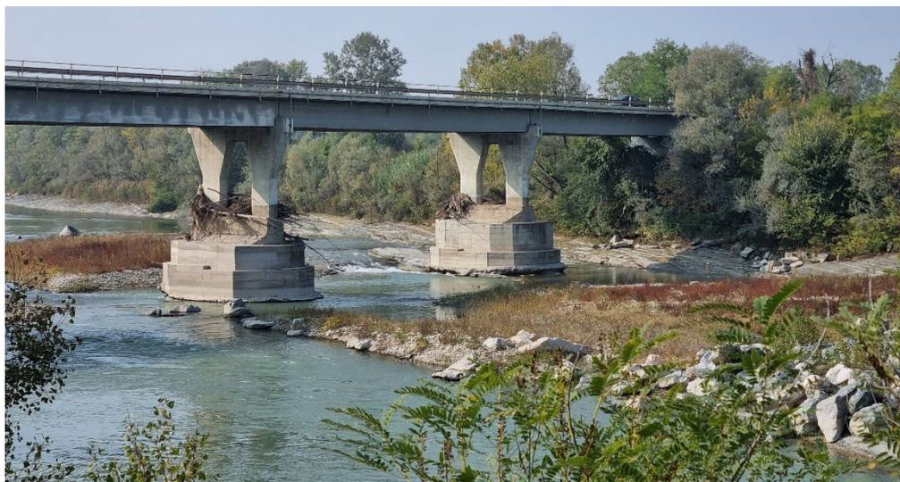
**Figura 15 – Ponte di Neive. In evidenza l’abbassamento del fondo alveo
