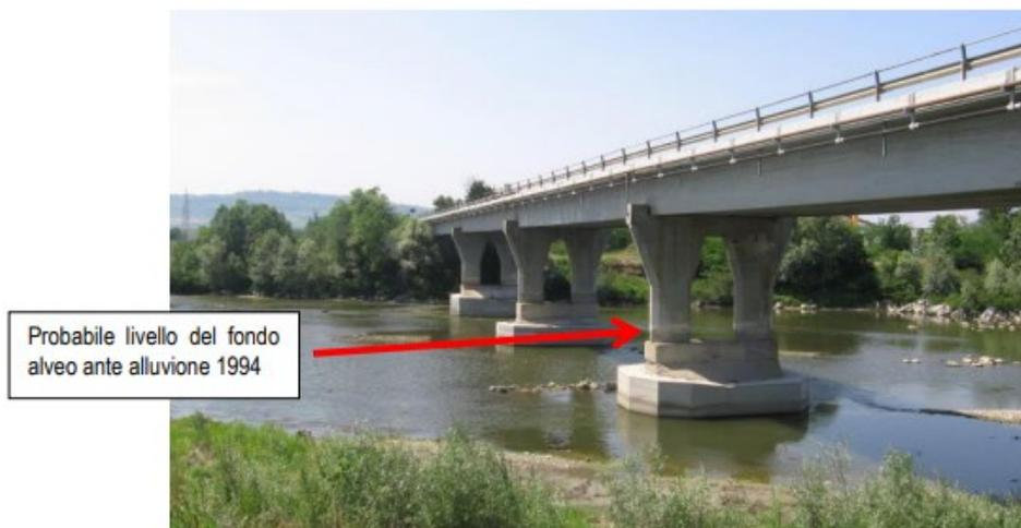
*Figura 12 – Vista da monte in sponda destra del Ponte della S.P. 3 per Neive – livello del fondo ante piena del '94*
