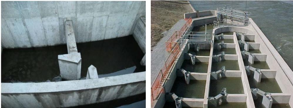
*Figura 16 - Soluzione con paratoie in CLS (Pini Prato, 2007) e Soluzione con paratoie in CLS e profilato metallico per formare il deflettore*
