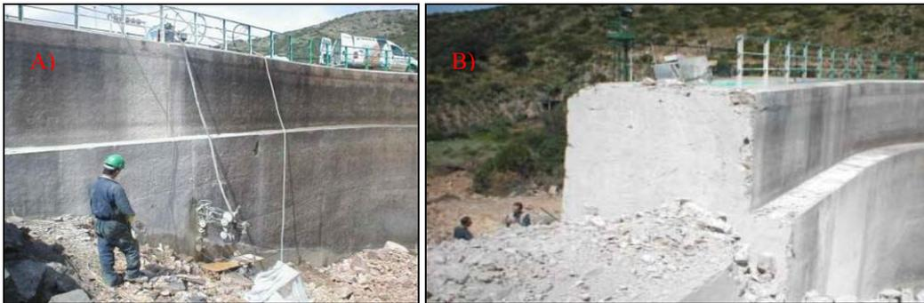
**Figura 2 – A) Sega a filo diamantato in azione su uno sbarramento in c.a. B) Risultato a operazione compiuta, il concio è stato rimosso senza danneggiare la struttura adiacente.**
