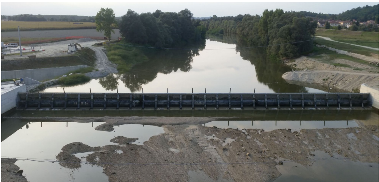
Figura 6 – Sbarramento gonfiabile scudato con singolo elemento elastomerico di gonfiaggio a valle di H=4,2 m e L=85 m analogo a quello previsto in progetto. Fase di innalzamento
