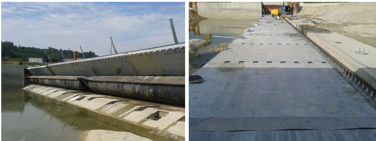
Figura 5 – Sbarramento gonfiabile scudato con singolo elemento elastomerico di gonfiaggio a valle di H=4,2 m e L=85 m analogo a quello previsto in progetto. Fasi di collaudo e gonfiaggio dell'elastomero (in sinistra) e fasi di installazione con sbarramento in posizione completamente abbattuta (in destra)
