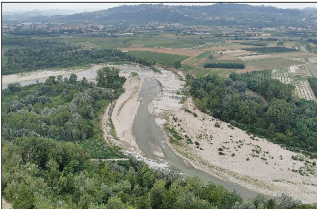
STATO DEI LUOGHI ANTE-OPERAM
