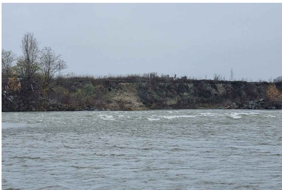
Figura 22 – Fenomeni di erosione accentuata in corrispondenza della battuta di sponda
