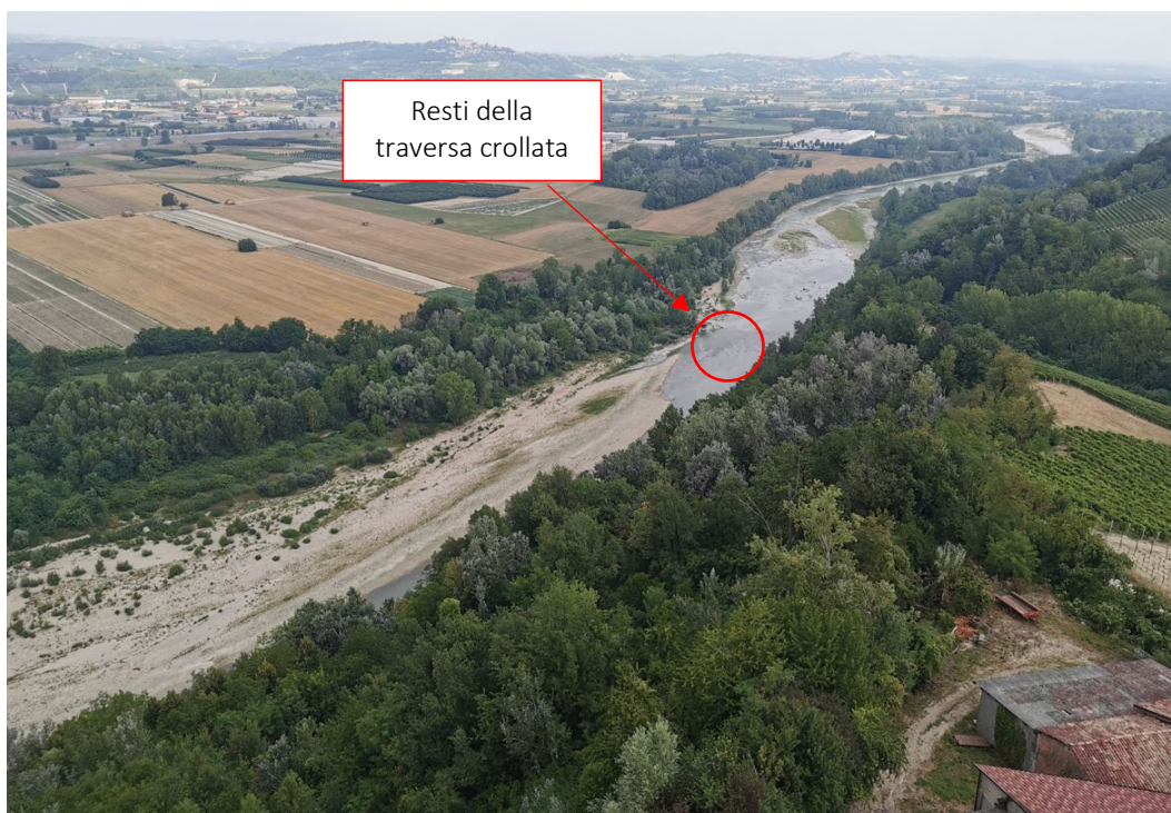
Figura 19 – Vista dell'area d'intervento dal centro storico di Barbaresco
