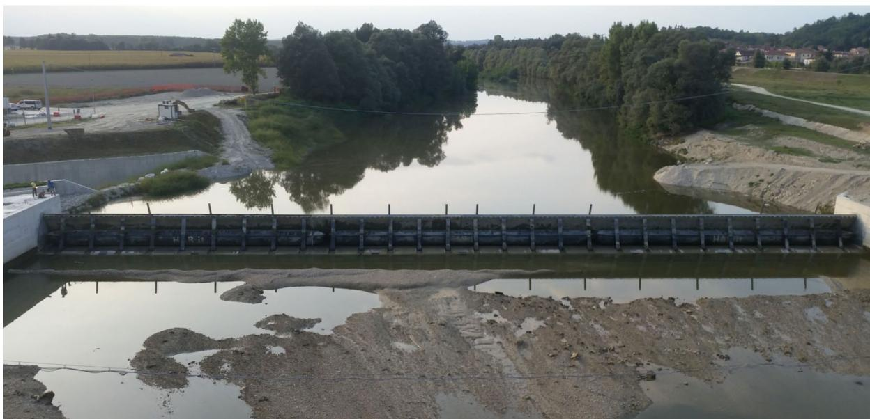
**Figura 7 – Sbarramento gonfiabile scudato con singolo elemento elastomerico di gonfiaggio a valle di  $H=4,2$  m e  $L=85$  m analogo a quello previsto in progetto. Fase di innalzamento**
