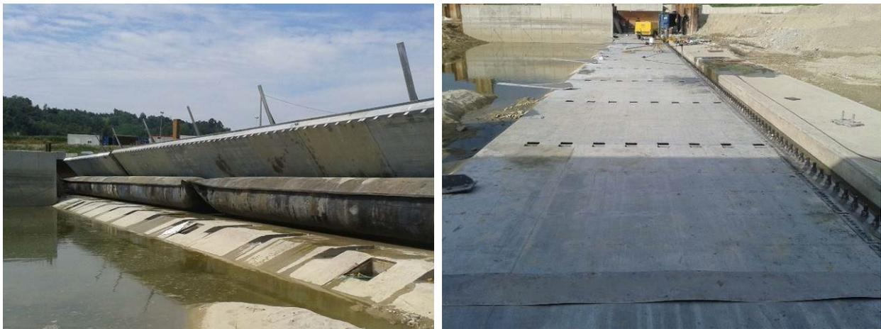
**Figura 49 – Sbarramento gonfiabile scudato con singolo elemento elastomerico di gonfiaggio a valle di  $H=4,2$  m e  $L=85$  m analogo a quello previsto in progetto. Fasi di collaudo e gonfiaggio dell'elastomero (in sinistra) e fasi di installazione con sbarramento in posizione completamente abbattuta (in destra)**
