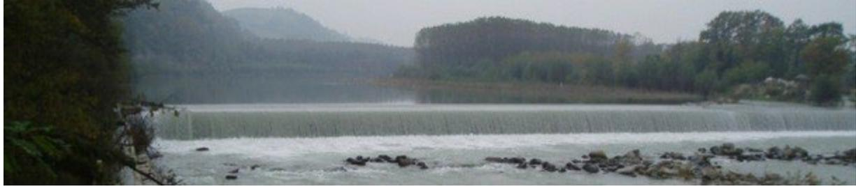
*Figura 32 - Traversa del 2002 crollata nel 2010.*
