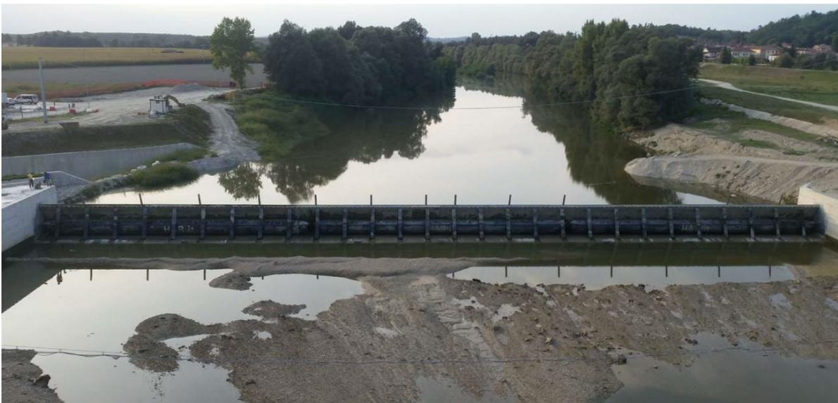
**Figura 50 – Sbarramento gonfiabile scudato con singolo elemento elastomerico di gonfiaggio a valle di  $H=4,2$  m e  $L=85$  m analogo a quello previsto in progetto. Fase di innalzamento**
