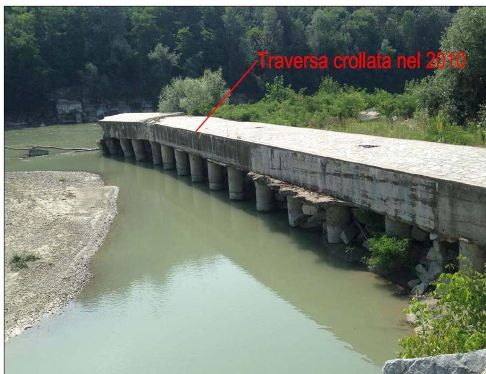
*FOTO 6 - Vista di dettaglio a valle della traversa esistente al 2015, ad oggi il livello idrico è inferiore e l'alveo a valle della traversa è completamente emerso. In ALLEGATO 1 le immagini del 2022*
