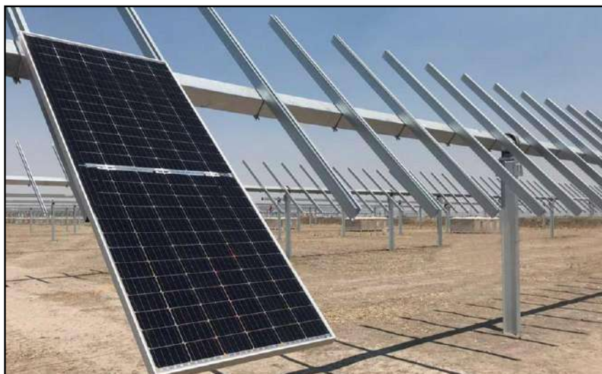
Figura 5 – esempio di tracker fotovoltaico
