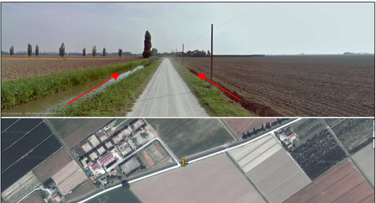
Figura 4.1 – Immagine della strada alla stato attuale con lo Scolo Riolo (in sinistra) e il fosso di guardia stradale in destra.
