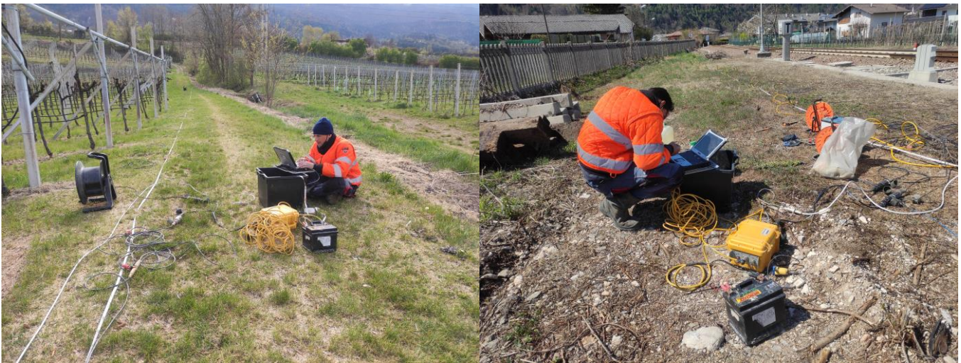
Figura 5 - Fasi di acquisizione
